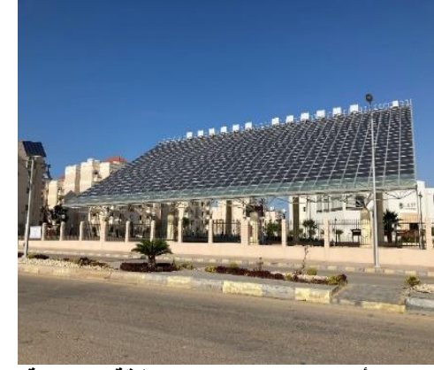
ألواح توليد الكهرباء بالطاقة الشمسية شفافة وتسمح بالرؤية بجامعة E-JUST
