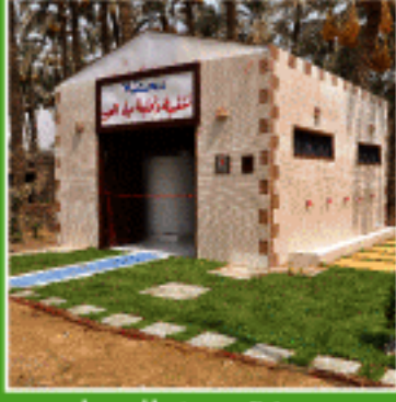
● محطة ضخ المياه
